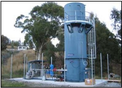
Landfill Gas Flare
